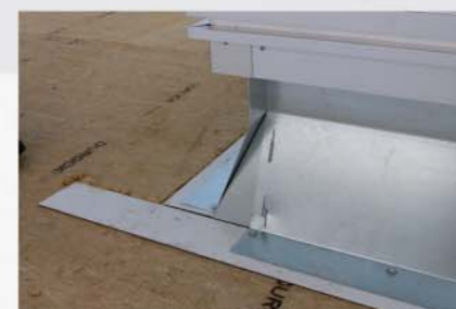
Stecksocket vor der Einklebung
