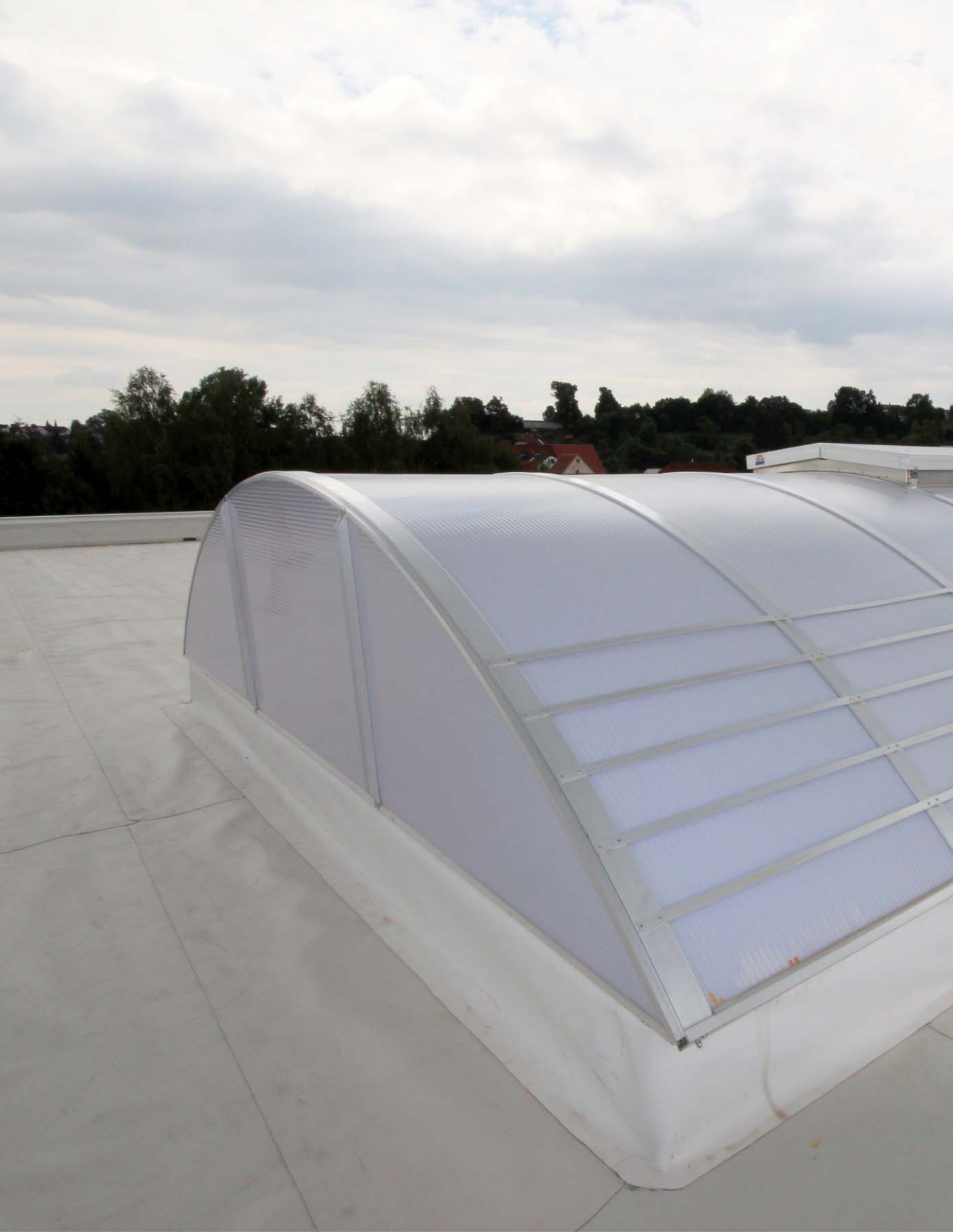
Bild: EUROLIGHT mit einer Öffnungsbreite von fünf Metern und über einen Radiusflansch aufgesetzte PHÖNIX.
