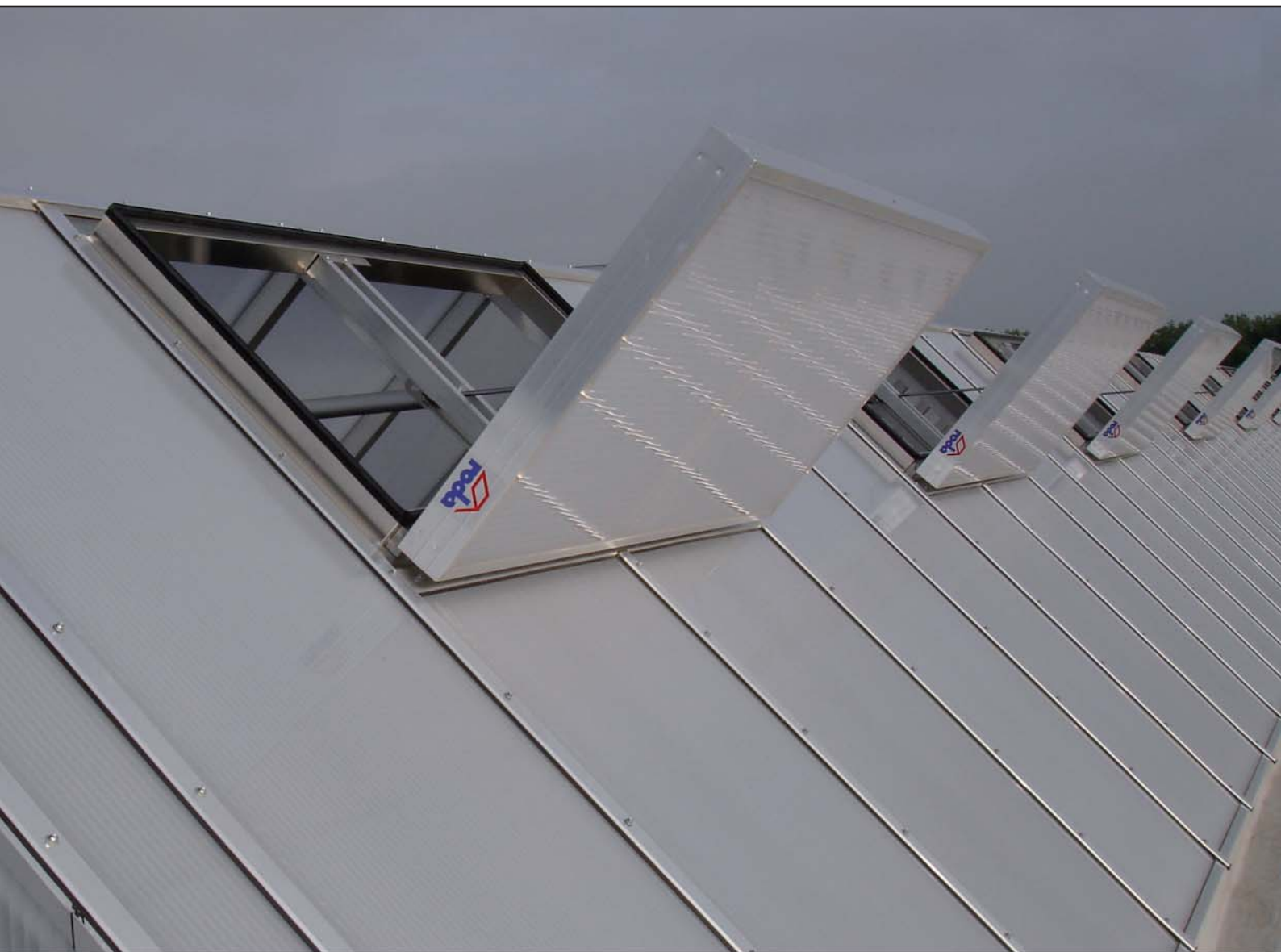
Großes Bild: DELTALIGHT mit opalen PC-Mehrstegeplatten und integrierten NRWGs Typ PHÖNIX als Einzelklappe.
