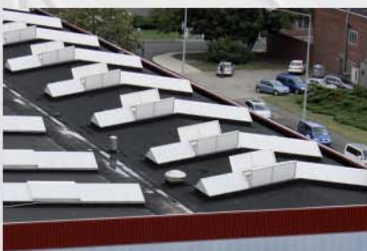
DELTALIGHT auf einer Montagehalle ...
