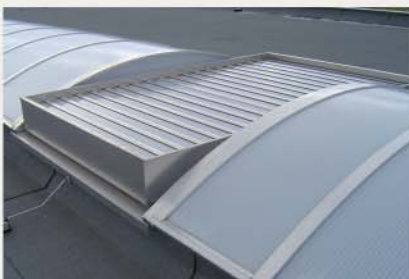
In ein Tonnenoberlicht integriertes Gerät
