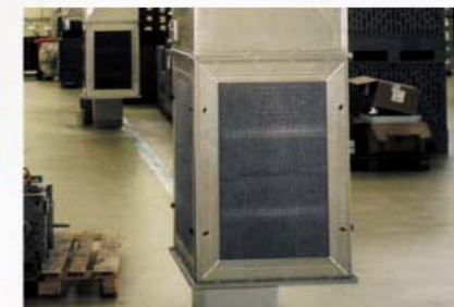
Displacement diffuser
