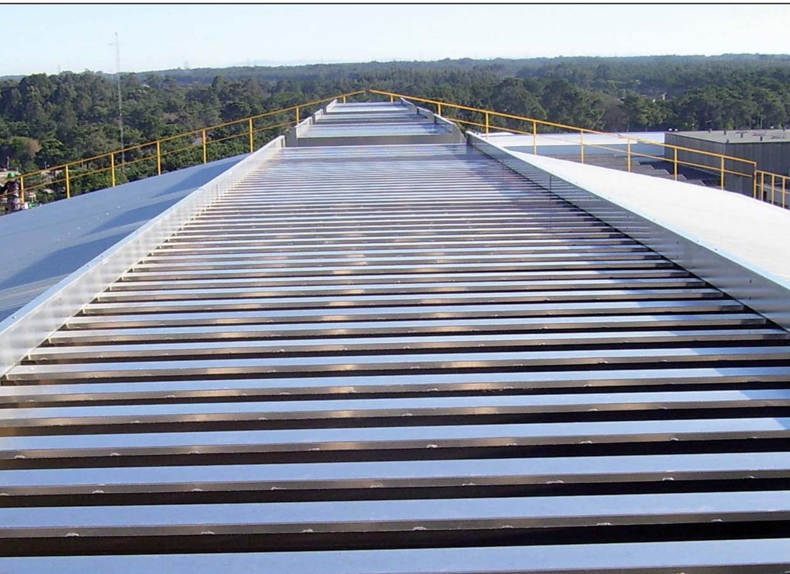
Großes Bild: Labyrinthlüfter Typ AIRSTAR, der sich über die gesamte Länge des Firstes einer Produktionshalle erstreckt.
