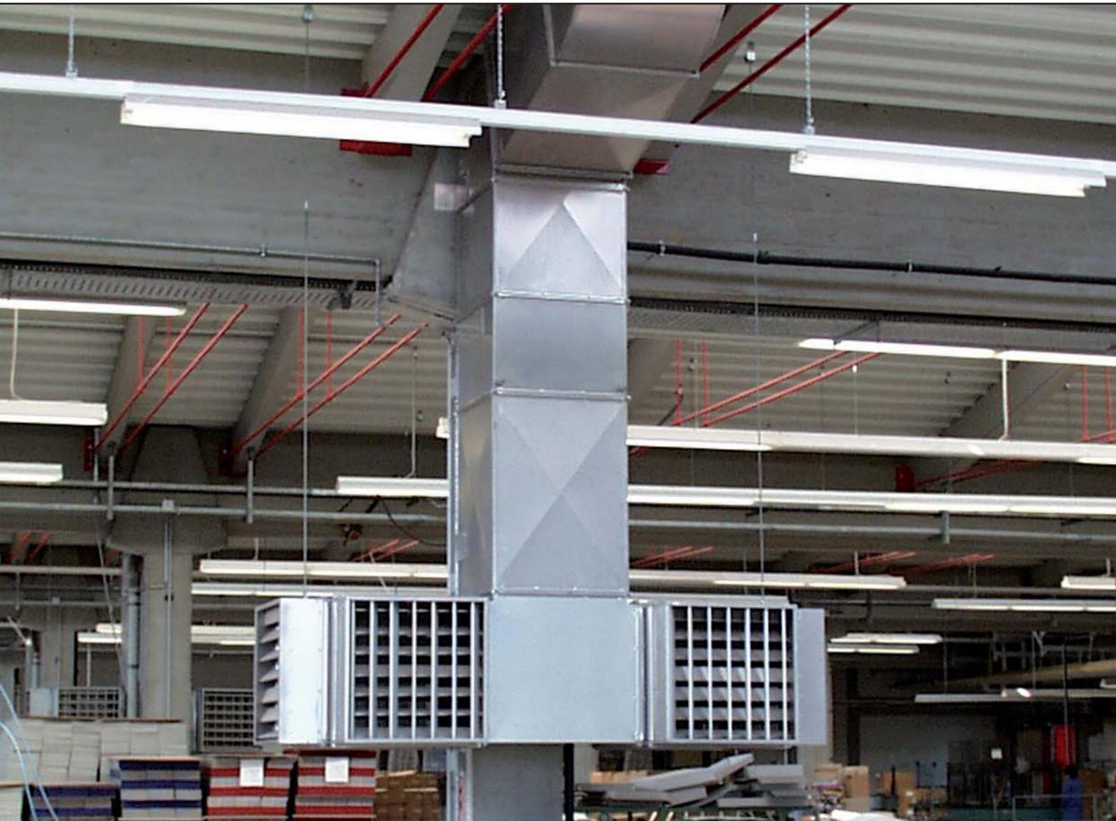
Großes Bild: AIRSYSTEM mit manuell einstellbaren Lüftungsgittern.
