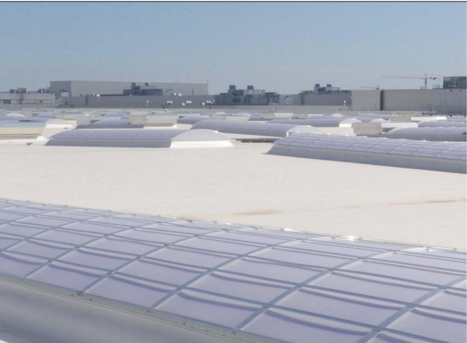
Großes Bild: EUROLIGHT mit Durchsturzicherung Typ PSP30 auf der großen Produktionshalle eines Automobilherstellers.
