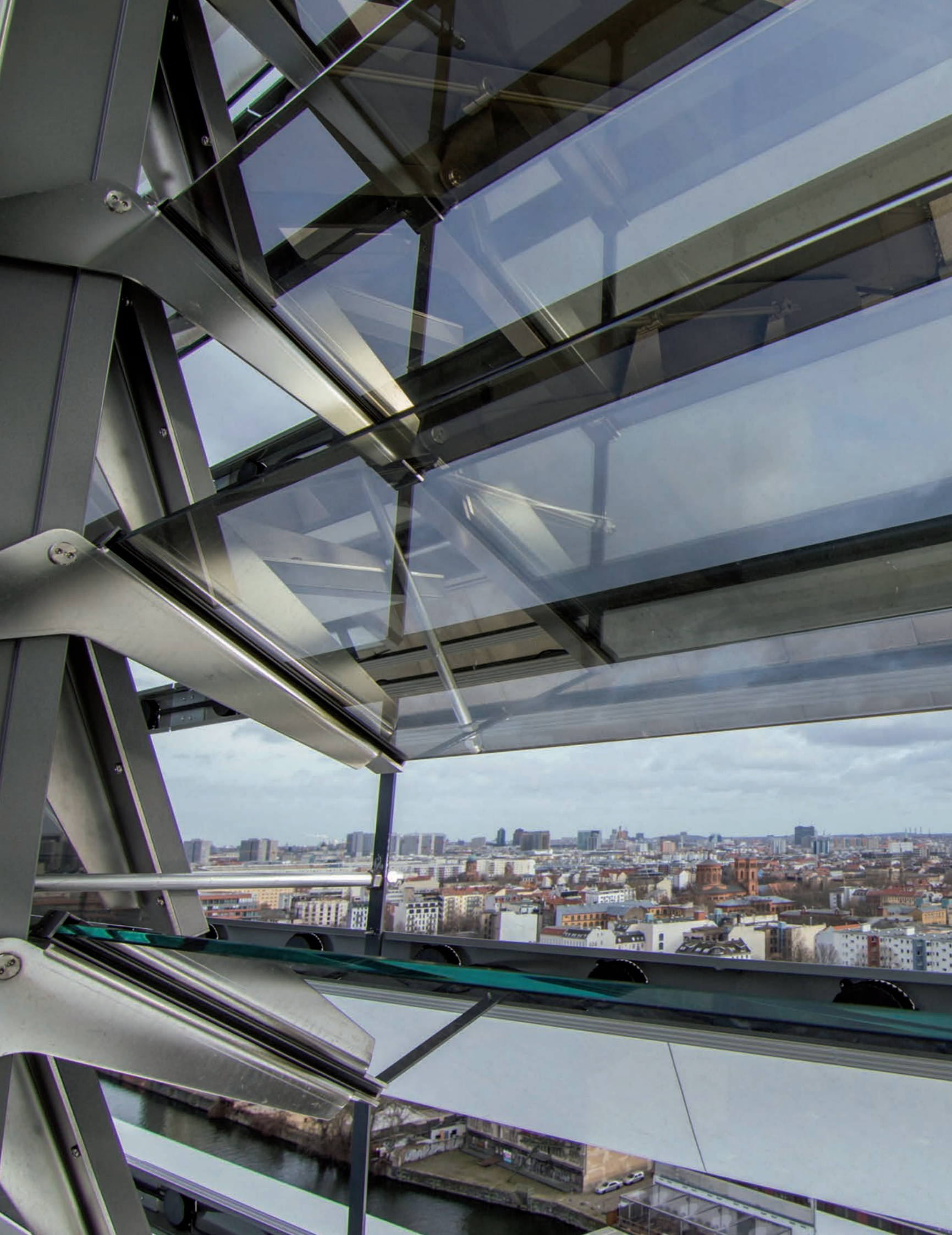
Bild: EAL Ausstelllamelle im Detail.
